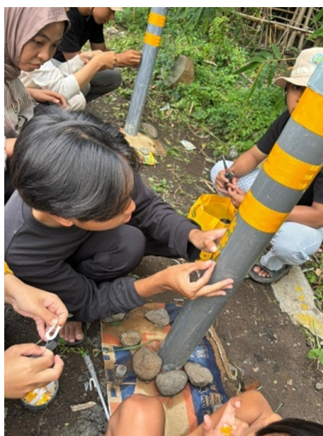
Gambar 5. Pemasangan stiker reflektif pada pipa paralon bekas sebelum fungsi malam hari diuji.
