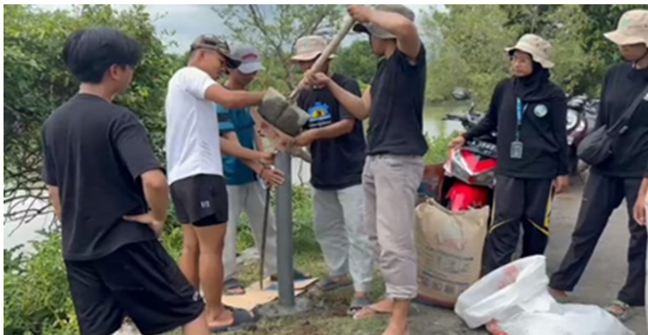
Gambar 4. Proses pengecoran dan penguatan pipa reflektor bersama warga dan tim pelaksana.
